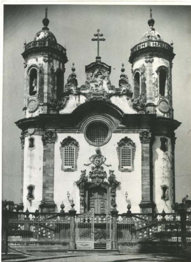
Figura 4 - Fachada frontal da Igreja de São Francisco de Assis - Fonte: ACI/IPHAN - Data: Década de 1940
