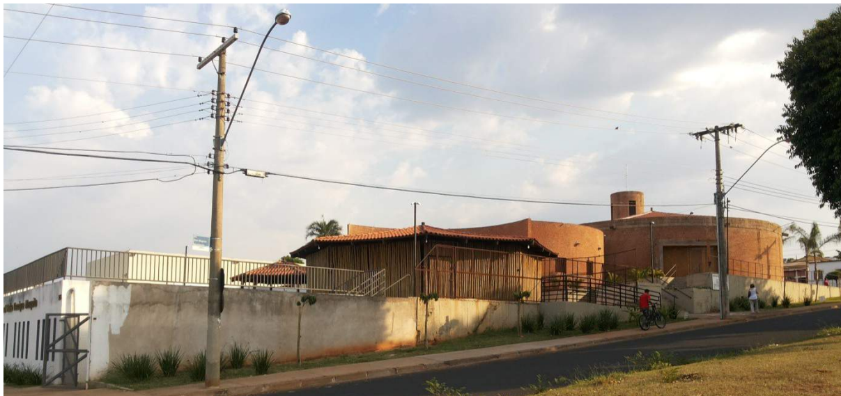
Figura 13 – Fotografia atual, após entrega do projeto de ampliação e restauro.
