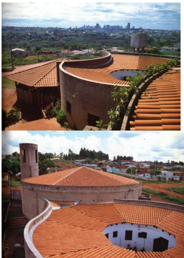
Figura 11 e Figura 12 – Fotografias aéreas, destaque para a platibanda-jardim na capela.
